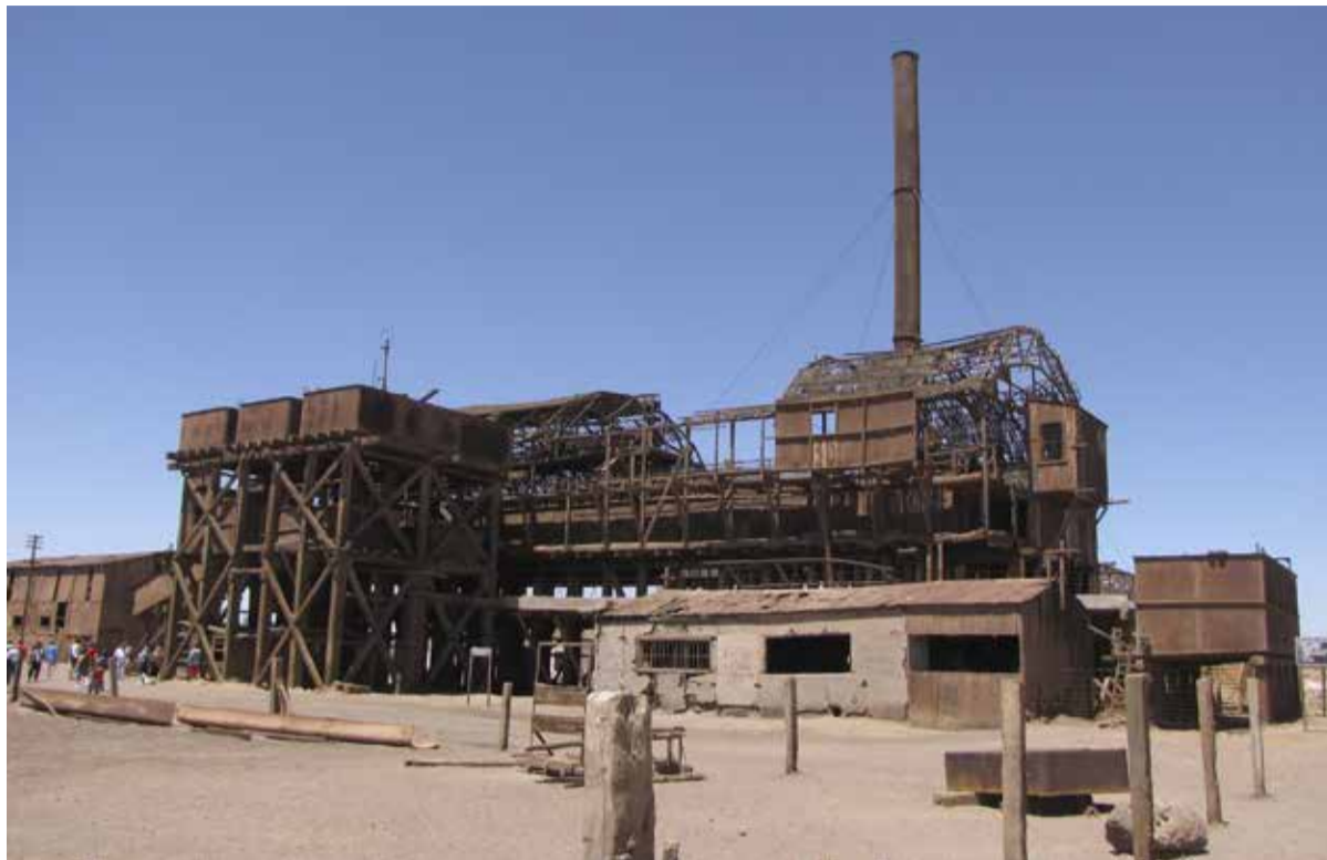
Planta de lixiviación, Oficina Santa Laura, región de Tarapacá (Fotografía: Elizaga, J. 2012. Archivo CNCR).
