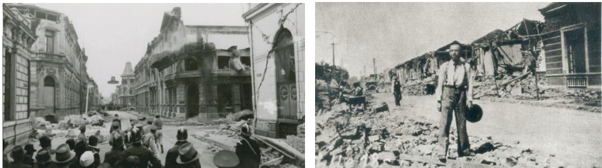
Fig. 4 y 5. Imágenes de las calles de la ciudad destruida por el terremoto. Ver fuente fotografías y planos históricos
