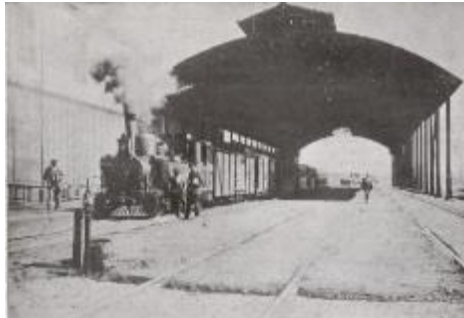
Fig.9. Estación de Ferrocarriles de Chillán con el tren ramal a Recinto. Ver fuente fotografías y planos históricos
