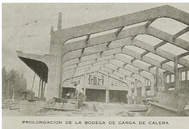
Fig.13-a. Ampliación de las Bodegas de Carga de Calera, 1941. Fuente: 58a Memoria EFE, pág. 105
