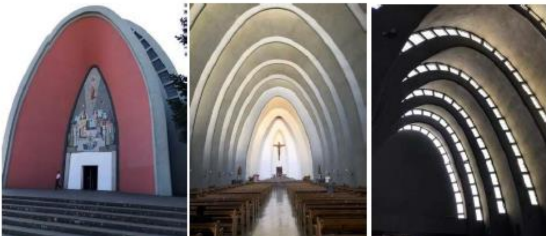
Fig.21. La Catedral de Chillán construida en 1942 con hormigón armado, ejemplo imponente y emblemático de la avanzada arquitectura moderna que se desarrolló después del terremoto de 1939. Fotografías actuales tomadas por el Consultor, febrero 2021.
