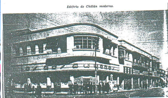
Fig.16. Edificio de los Dos Cuyanos, único en su tipo en 1939 antes del Terremoto. Este edificio se mantuvo en pie hasta la actualidad.
