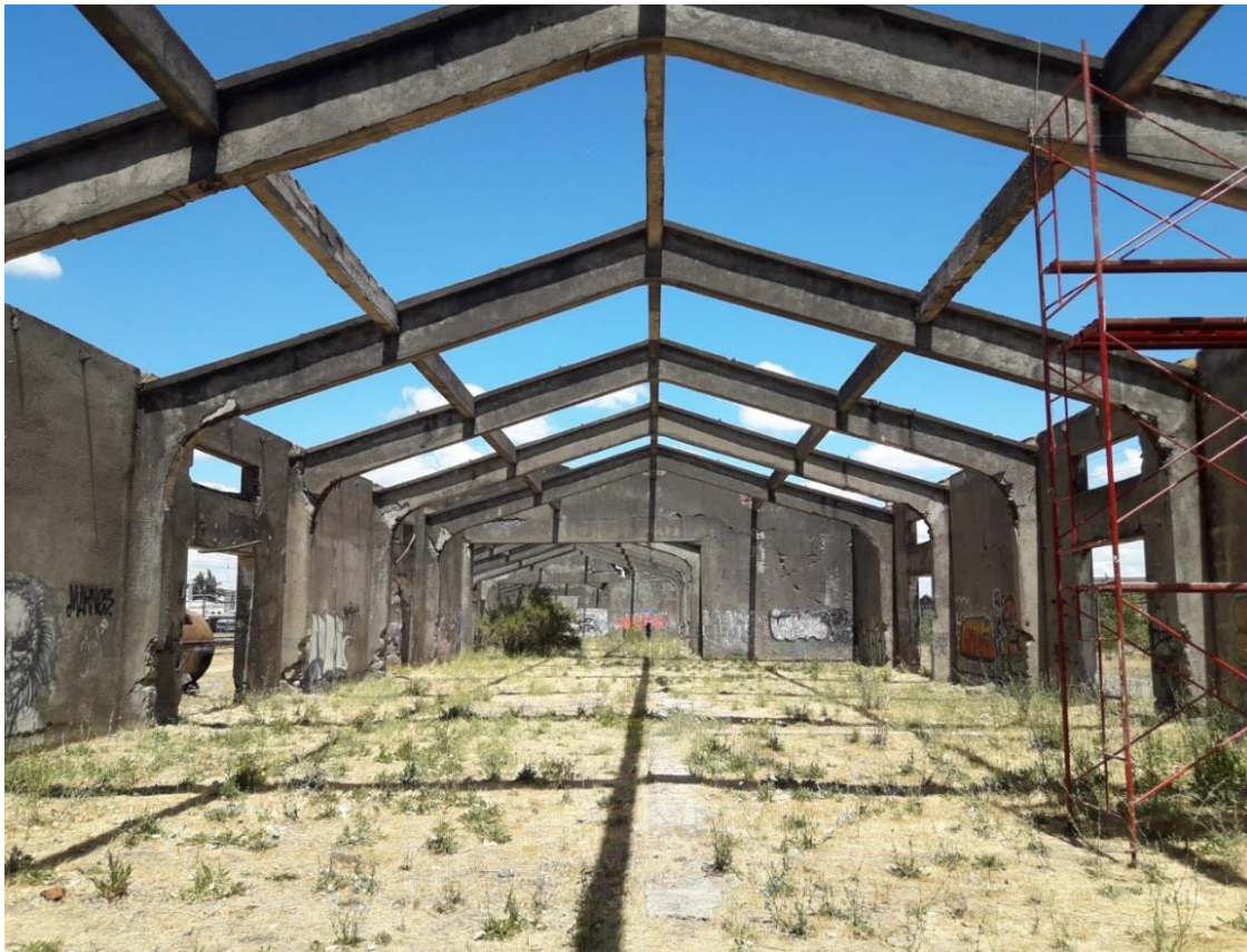
Vista general de la nave norte – Imagen Equipo consultor estructural
